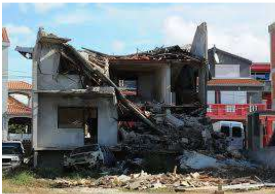
Рушење објекта земљотресом јачине 7 степени Меркалијеве скале
